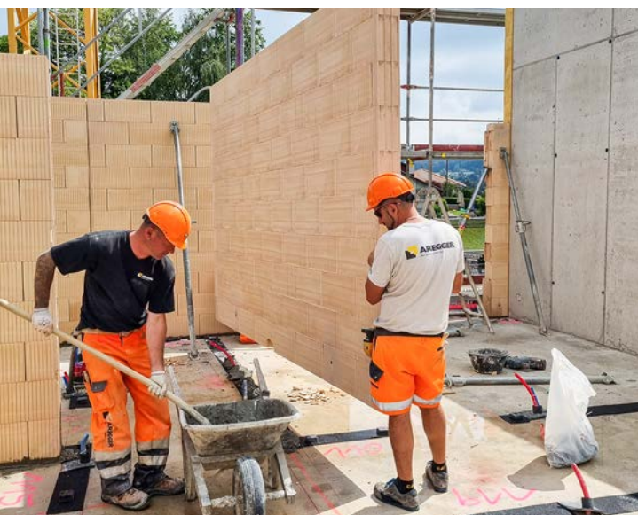
Ein fertiges Mauer-Element wird versetzt.
