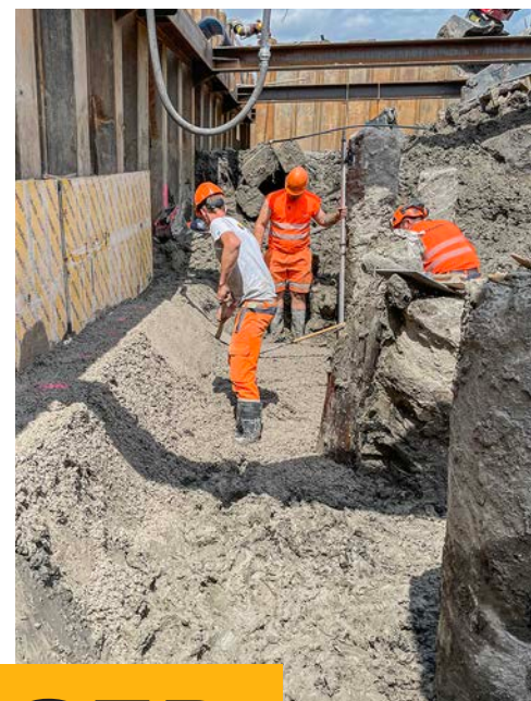
Die Nähe zu den Bahngleisen erfordert vom Aregger-Team stete Aufmerksamkeit.
