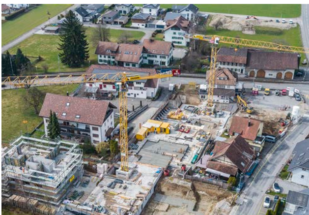
Oben: Die Rühlwände wurden mittels Stahlträger gestützt. Unten: Vogelperspektive über die verwinkelte Baustelle.
