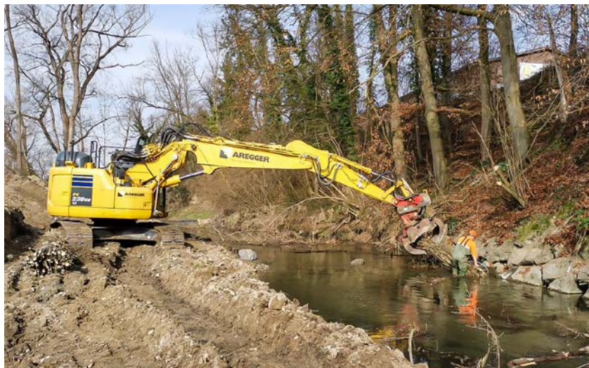
Die Ron wandelt sich: In Root werden alte Stützmauern entfernt und der Bach verbreitert. Auf einem Abschnitt wird er demnächst durch grosse stählerne Durchlässe fließen.
